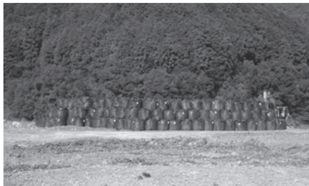
建設廃材を活用した大型土嚢
