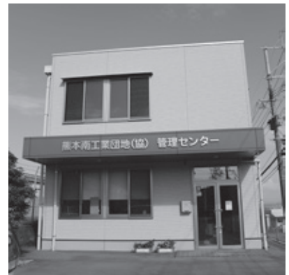
熊本南工業団地協同組合 管理センター
