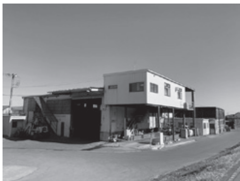
組合事務所棟(右)と併設されている廃棄物処理工場(左)
