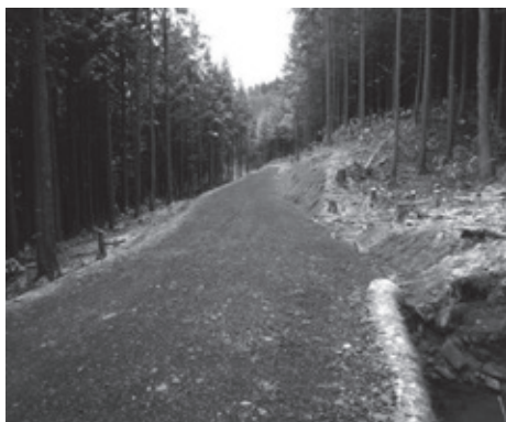
独自の新工法で整備された作業道
