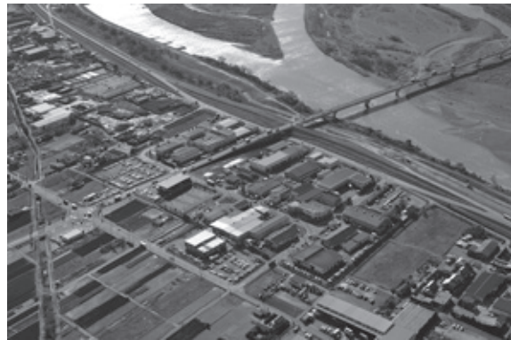
一級河川天竜川沿いに位置する工業団地全景
