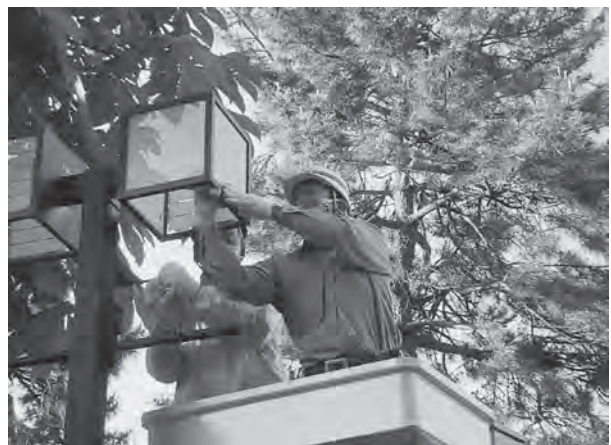
高所作業車での作業
