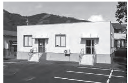
再生後の組合会館
