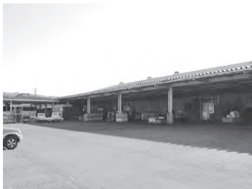
冷凍冷蔵倉庫（プラットフォーム）
