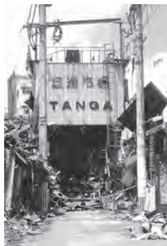
8月10日火災後の様子
