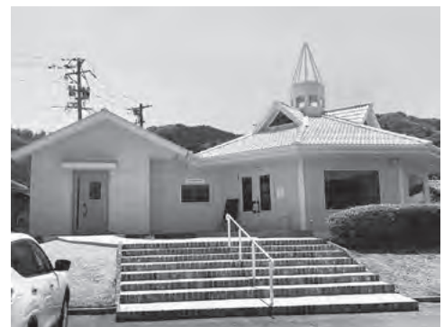
改装された店舗
