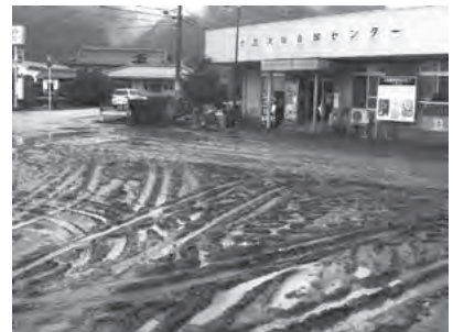
被災後の組合会館
