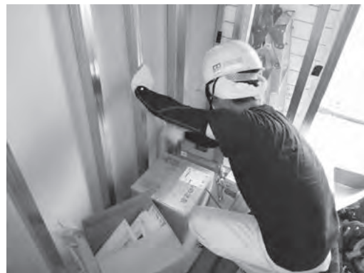
LPガス設備設置施工現場
