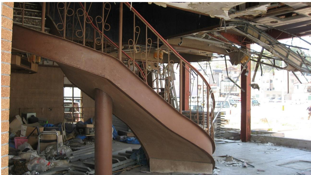
解体が進まず手つかずとなっている建物
